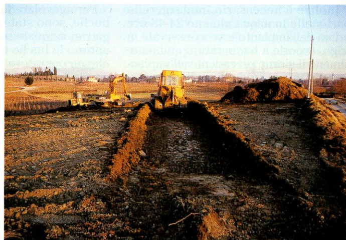
Foto 1 - L'analisi del terreno è la prima operazione da effettuare per una buona riuscita del futuro vigneto. Il prelievo va eseguito con modalità ben precise ed effettuato da personale competente. Foto 2 - In terreni pesanti e umidi risulta importante l'uso del drenaggio per lo smaltimento delle acque in profondità
