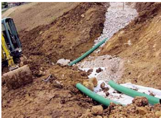
Foto 5 Durante i lavori di sistemazione vengono realizzati i necessari drenaggi sottosuperficiali. Di norma sono formati da cassonetti di ghiaia posti alla profondità necessaria con alla base un tubo corrugato e fenestrato e avvolti o meno da un geotessile per evitare che con il tempo si intasino. Sono fondamentali in quegli appezzamenti in cui c'è acqua stagnante o di risorgiva per evitare l'appesantimento del terreno con conseguenti smottamenti
